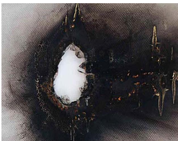
Obrázok A.14 – Dôsledky elektrického oblúka v module na spoji fotovoltaického článku a vodiča
