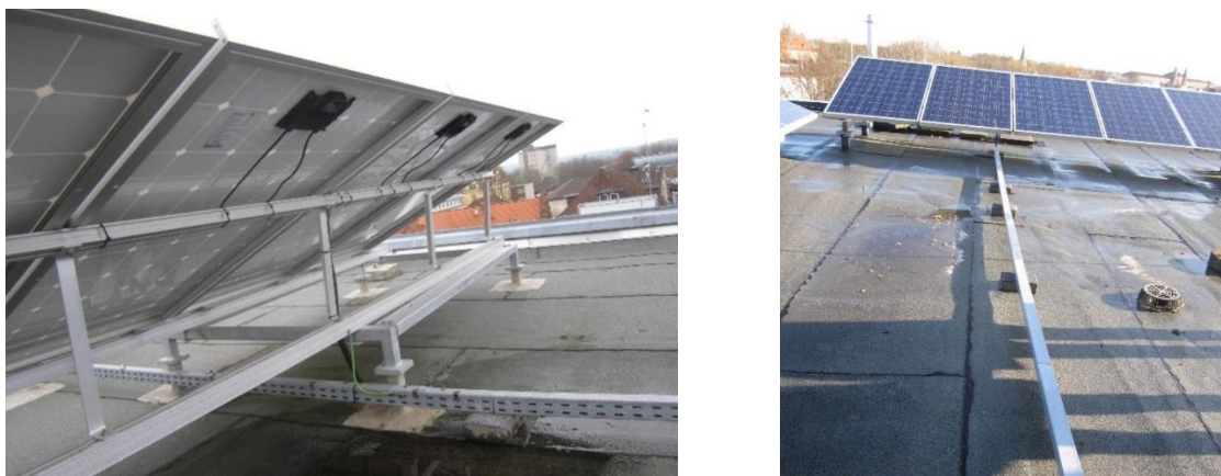
Obrázok 14 – Príklad správnej inštalácie káblov v káblových kanáloch
