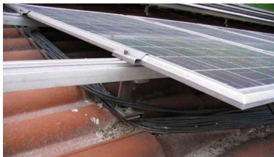
Obrázok A.15 – Nesprávne uloženie káblov
