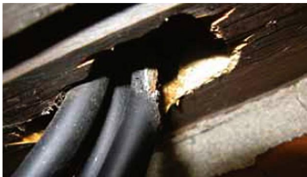
Obrázok A.18 – Recept na požiar: kábel vedený cez drevený prvok s ostrými hranami
