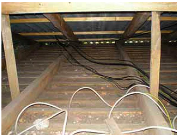
Obrázok A.23 – Nesprávne uložené káble jednosmerného napätia v podkroví
