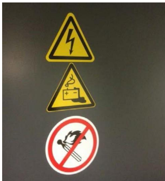
Obrázok 20 – Výstražné štítky pre olovené batérie
