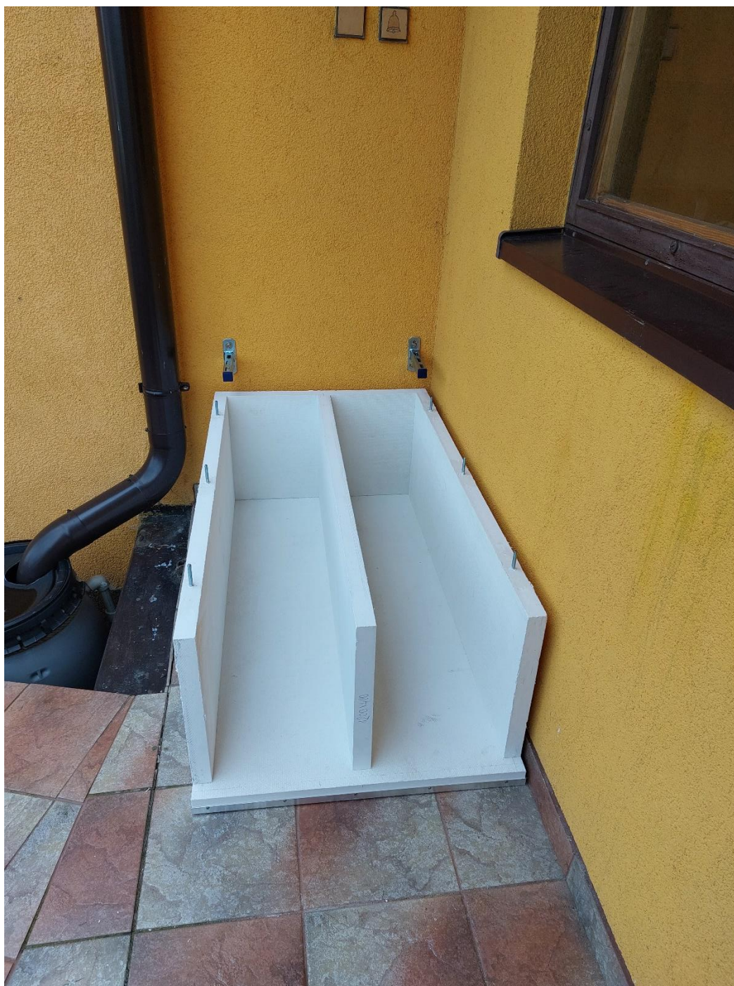
Obrázok A.1 – Umiestnenie ochrannej konštrukcie na skladovanie elektrickej kolobežky v exteriéri
