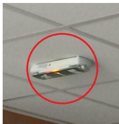
Obrázok 4 – Nesprávne použitie núdzového svietidla s bezpečnostnou značkou
