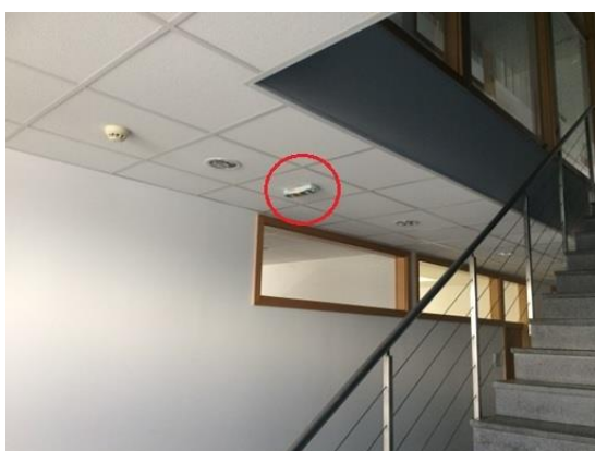
Obrázok 4 – Nesprávne použitie núdzového svietidla s bezpečnostnou značkou
