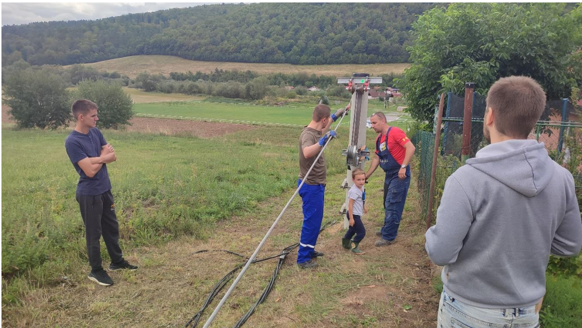
Obr. 17 Kotvenie a napínanie lana 110-AL1/22-ST1A
