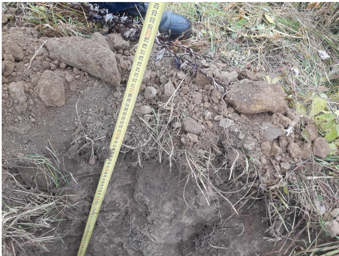
Obr. 6 Hĺbka jamy pre osadenie železobetónového stĺpa
