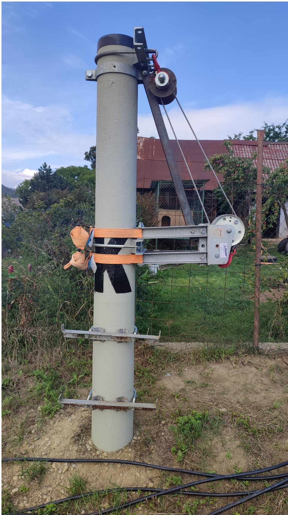
Obr. 12 Výzbroj stĺpa "K"
