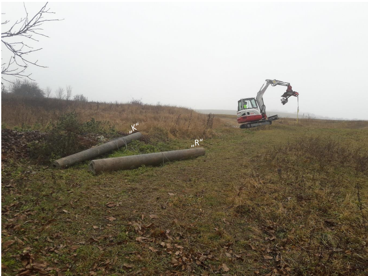
Obr. 3 Železobetónové stĺpy "R" a "K"
