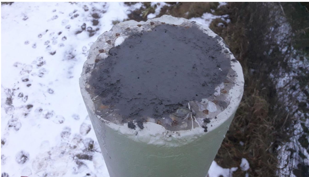
Obr. 9 Výplň stĺpa "K" betónom C30/37 vrátane oceľových prútov \varnothing 10
