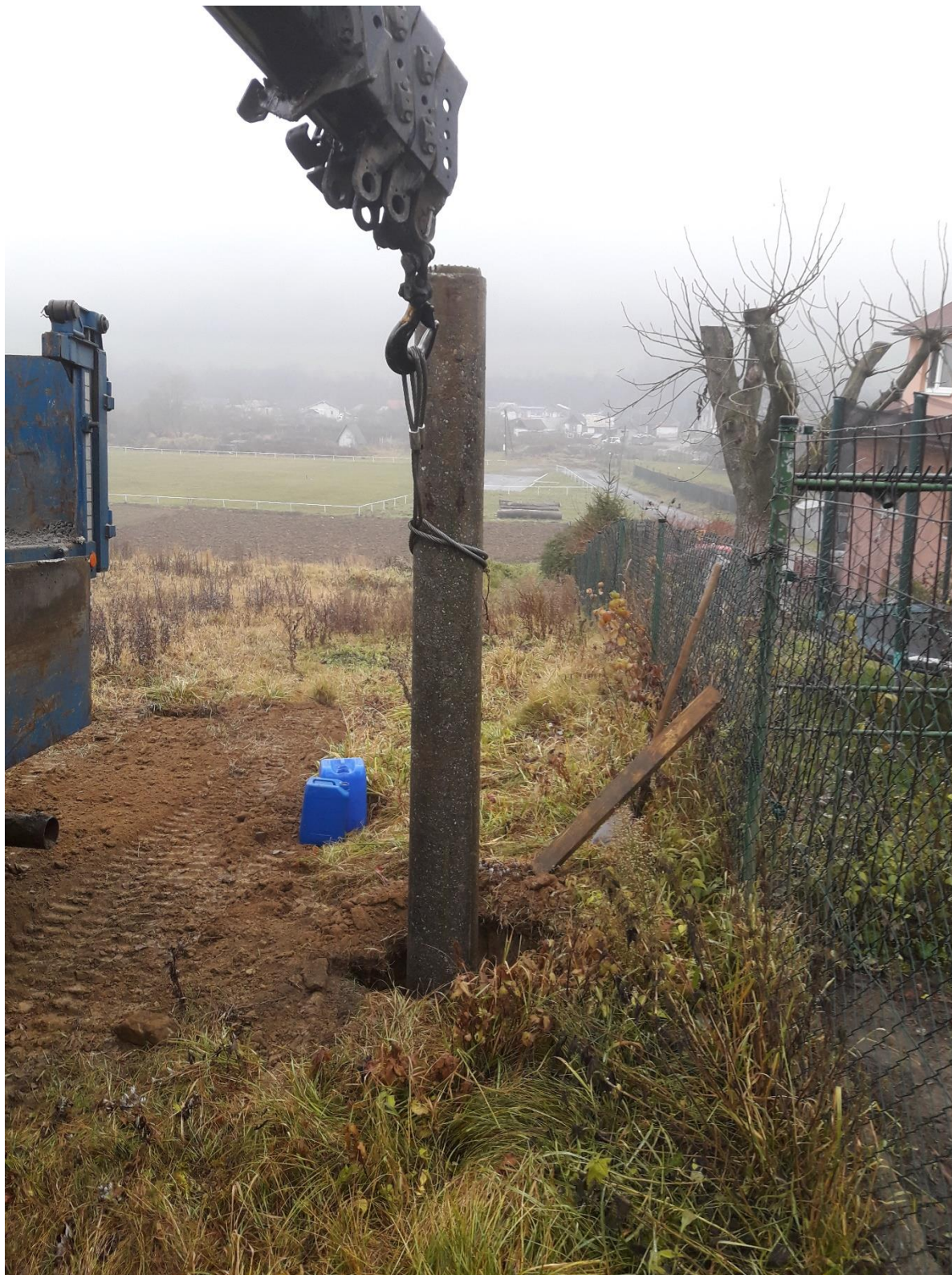
Obr. 7 Osadenie stĺpa "K" do vrtanej jamy
