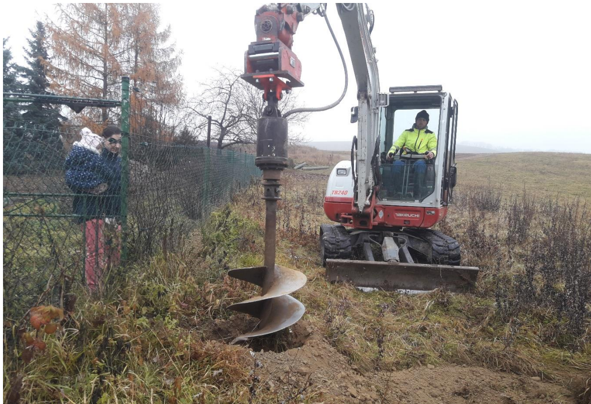
Obr. 4 Vŕtanie jamy pre osadenie stĺpa "R"
