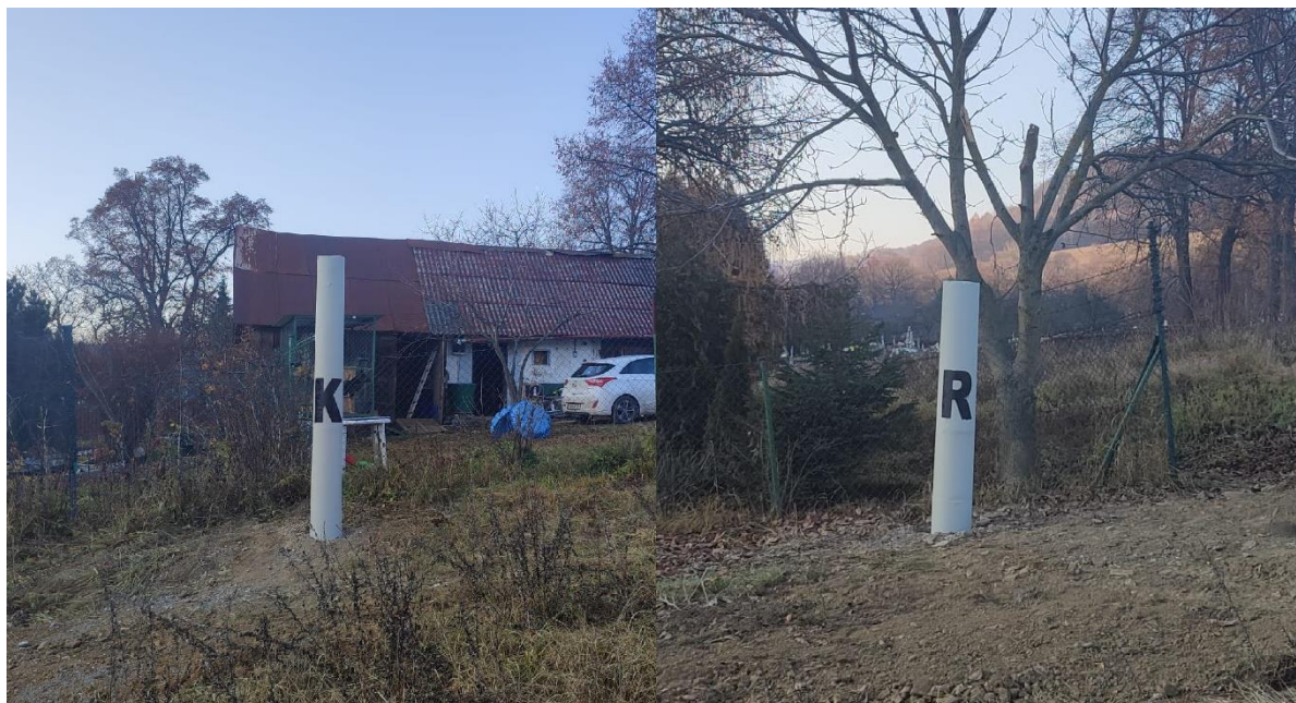
Obr. 10 Označenie železobetónových stĺpov "K" a "R"
