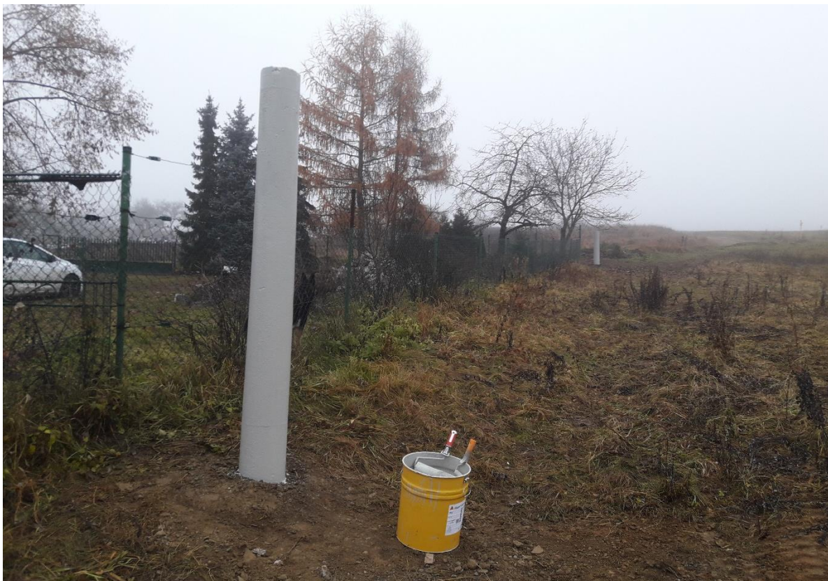
Obr. 8 Aplikácia náteru Sikagard-680 S Betoncolor na stĺpy „R“ a „K“
