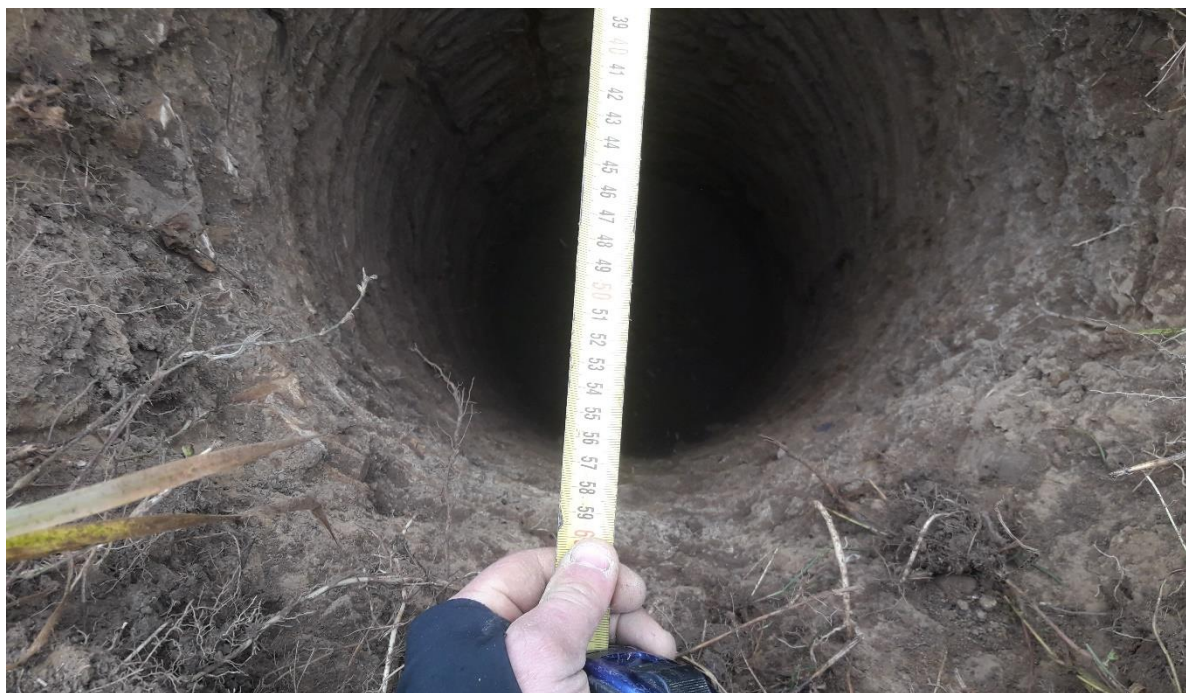
Obr. 5 Priemer jamy pre osadenie železobetónového stĺpa
