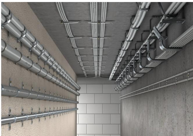
Obr1. : Príklad montáže OBO príchytiel
